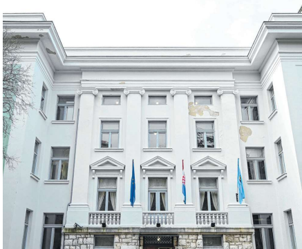
Tko će biti na čelu Sveučilišta u sljedećem mandatu trebalo bi se znati 25. travnja - zgrada Rektorata
